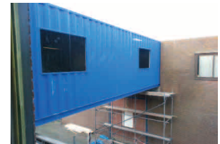
De loopbrug die in 2014 is gemaakt tussen beide gebouwen van Waypoint aan de Vliestroom.
